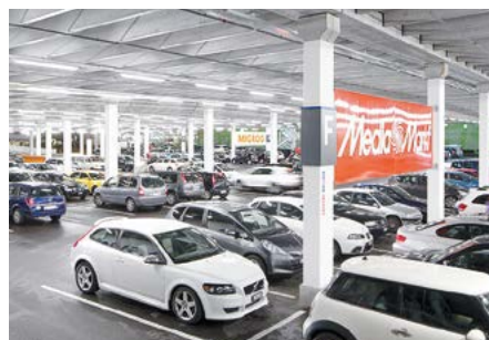
Für eine gleichmäßig helle Ausleuchtung wurde die LED-Feuchtraumleuchte SCUBA auf beiden Seiten der Fahrwege positioniert.
