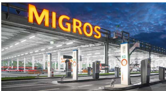
Komfort in einem Parkhaus entsteht durch großzügige Dimensionen bei der Flächenaufteilung genauso wie bei der Beleuchtungsstärke.
