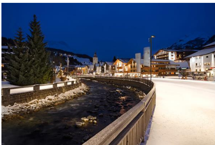
Bild 2: Der gleichnamige Fluss wird durch die neue Beleuchtung in das Ortsbild integriert.
