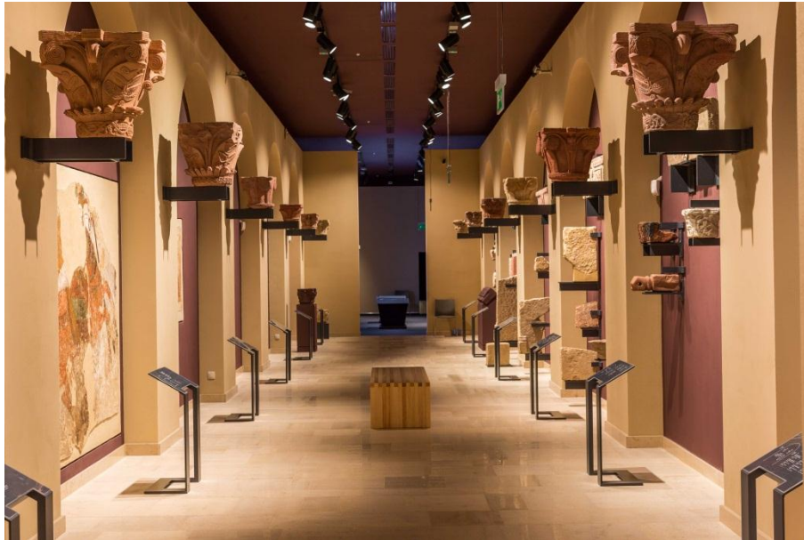
Bild 3: Für ein authentisches Kunsterlebnis sorgt die integrierte tunableWhite-Technologie, durch die für jedes Kunstwerk die Lichtfarbe individuell auf das Material, die Farbe und die Beschaffenheit abgestimmt werden kann.
