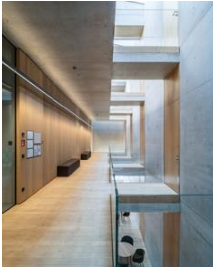
Bild 4: Eine lineare Pendelleuchte sorgt mit Hilfe eines Wallwashers und Indirektlichts nach oben für die Beleuchtung der Wand- und Deckenflächen und schafft Orientierung.
