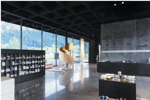
Bild 3: Für eine perfekte Raumakustik wurde in der offenen, bespielbaren Halle des Gebäudes eine Kassettendecke aus Holz mit dicken Polstern angebracht.
